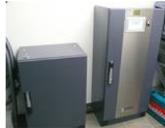
Die Sonnenbatterie der Größe L von Prosol Invest besteht aus zwei Speicherschränken und hat eine nutzbare Kapazität von 14,3 Kilowattstunden. Foto: Solarpraxis AG/Mirco Sieg
